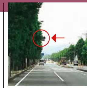
押しボタン式の信号機です。街路樹の適正な管理をしつかり行かないと信号機の機能が損なわれます。直ぐに対応して頂きました。
