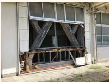
荒浜小学校。耐震工事による校舎の補強のお陰で津波に耐えることが出来たそうです。
